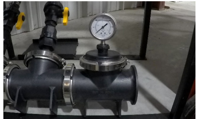
Kit de Montagem sistema de manômetro de 3"
